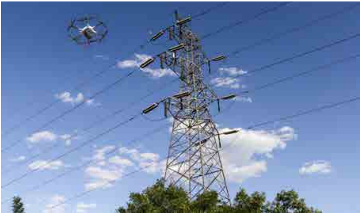
▲机载激光测量技术应用于电力巡检
