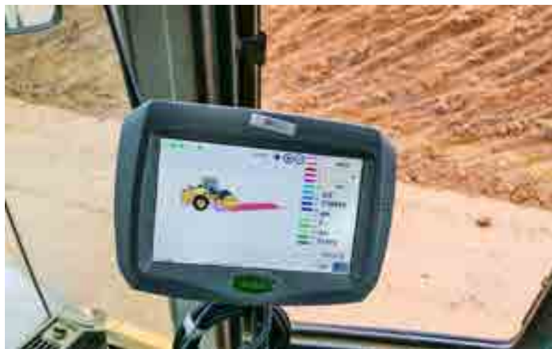
▲中海达北斗高精度定位定向车载控制终端引导作业人员施工
