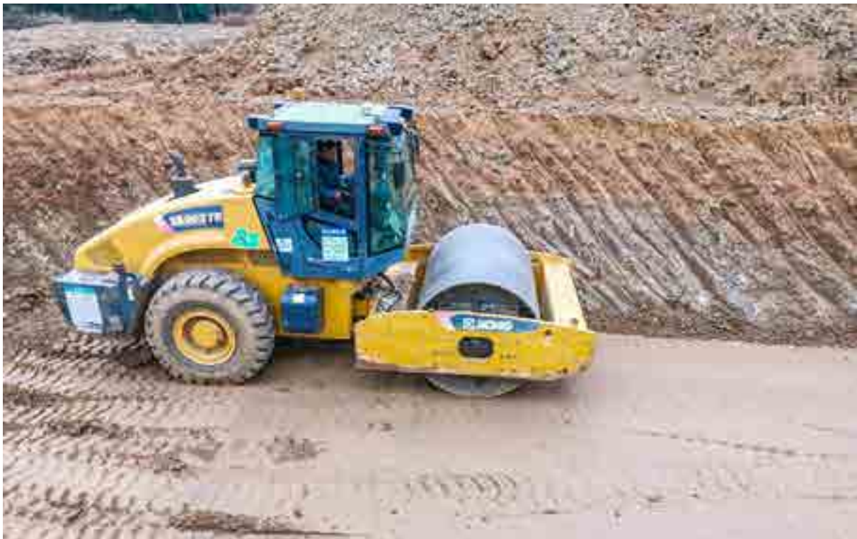
▲合枞项目使用中海达路面智能压实管理系统进行作业
