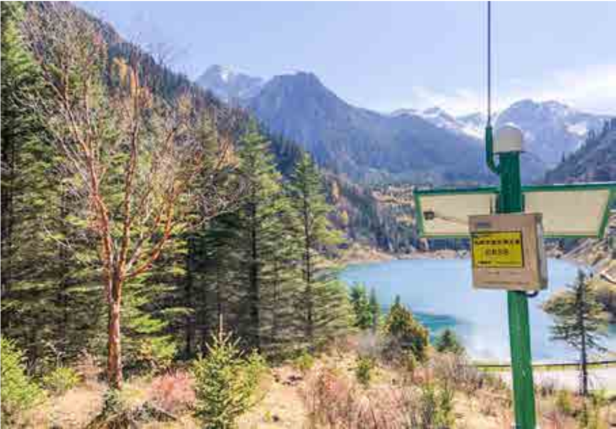
▲四川九寨沟景区布设 GNSS 地质灾害监测设备
