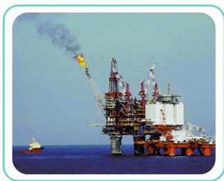
水下采油设备安装维护
